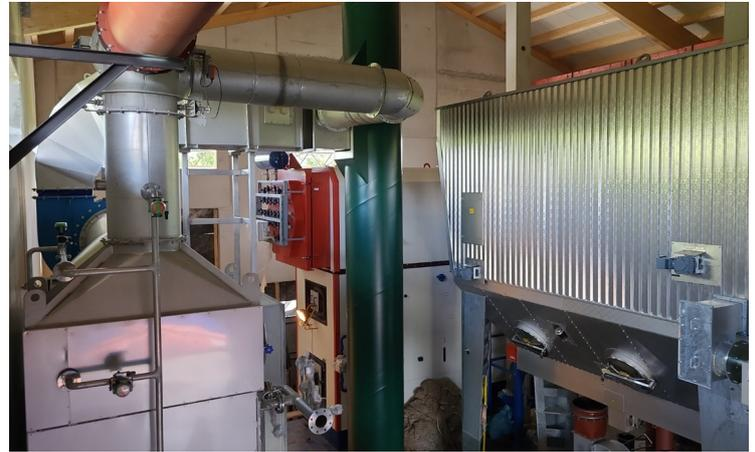
*Bild: Die zentralen Komponenten im Heizhaus – Biomassekessel (Mitte hinten), Elektrofilter (rechts) und Rauchgaskondensation (links) zur Abgasreinigung und Wärmerückgewinnung*
