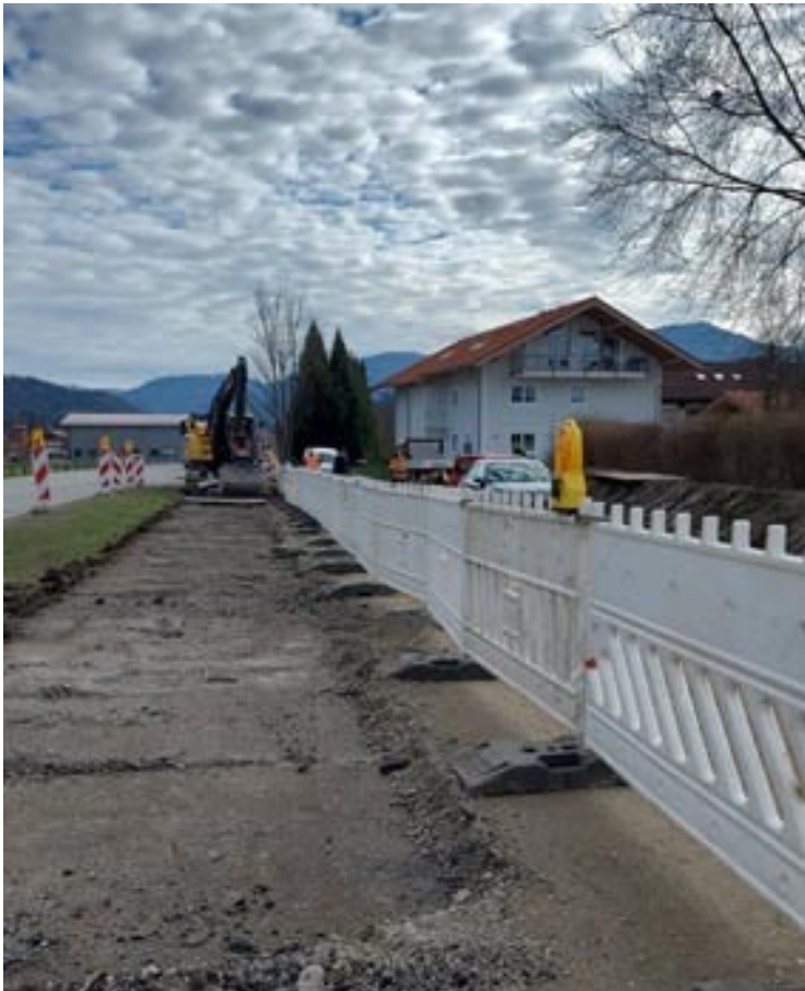
Bild: die ersten Arbeiten am Radweg (von Pettendorf kommend)
